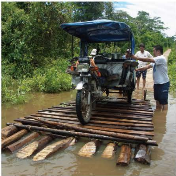
雨季になると道路が水没する。
